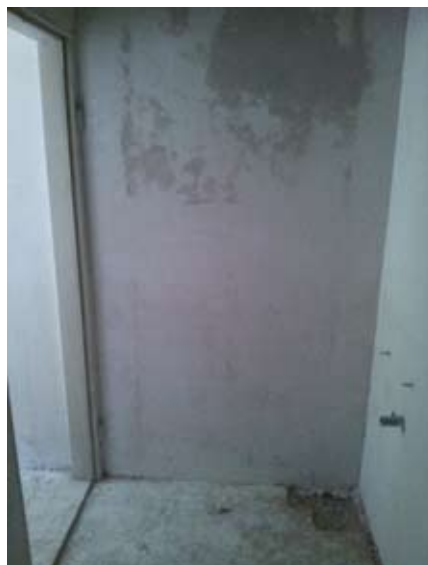
Bevor der Putz nicht getrocknet ist, kann mit den Fliesen nicht begonnen werden
