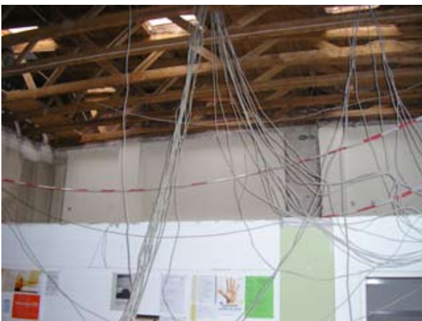
Der Gemeindesaal während der Baumaßnahmen
