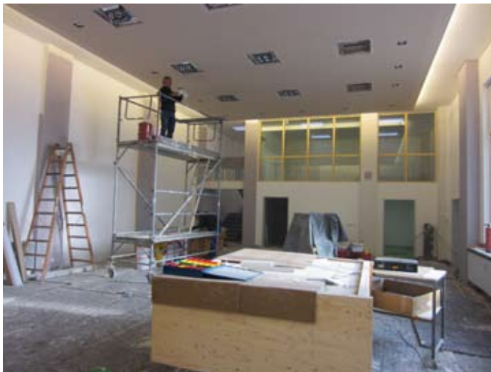
Der Gemeindehausumbau: hier ist der Saal in neuer Gestalt noch im Werden
